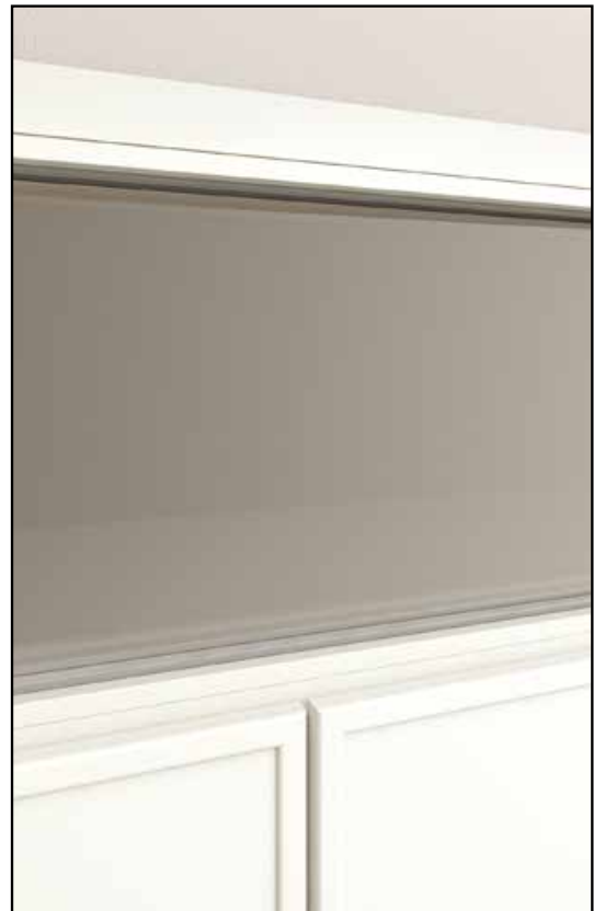
Particolare : vista chiusura in alto tra le due ante.
