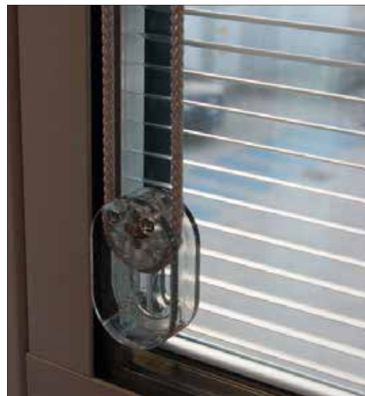
Particolare veneziana sistema di azionamento a corda
