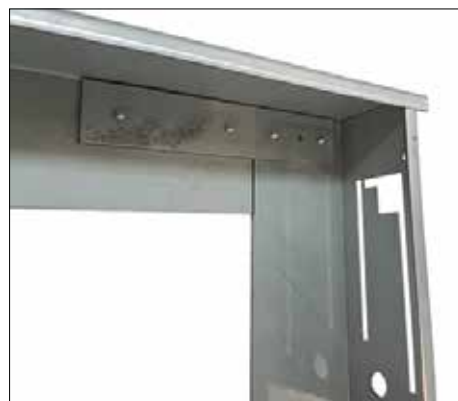
Particolare assemblaggio angolo.
