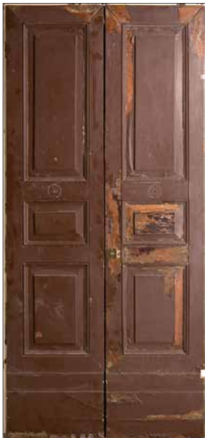
Prima del restauro.
