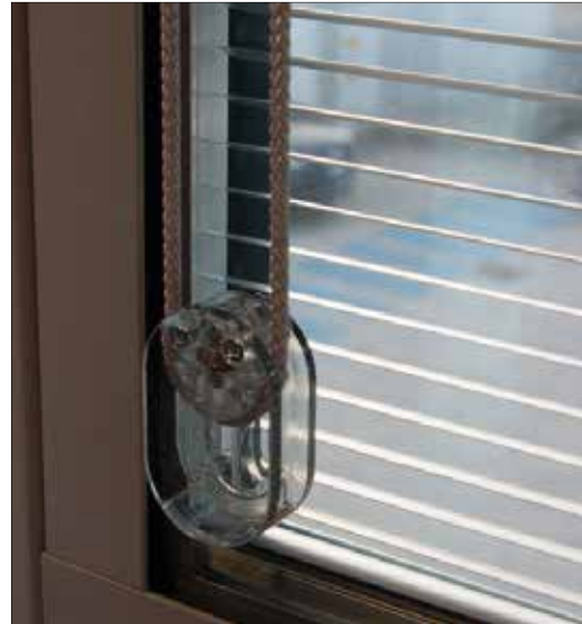
Particolare veneziana sistema di azionamento a corda
