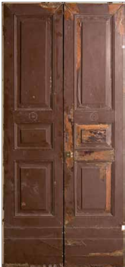
Prima del restauro.
