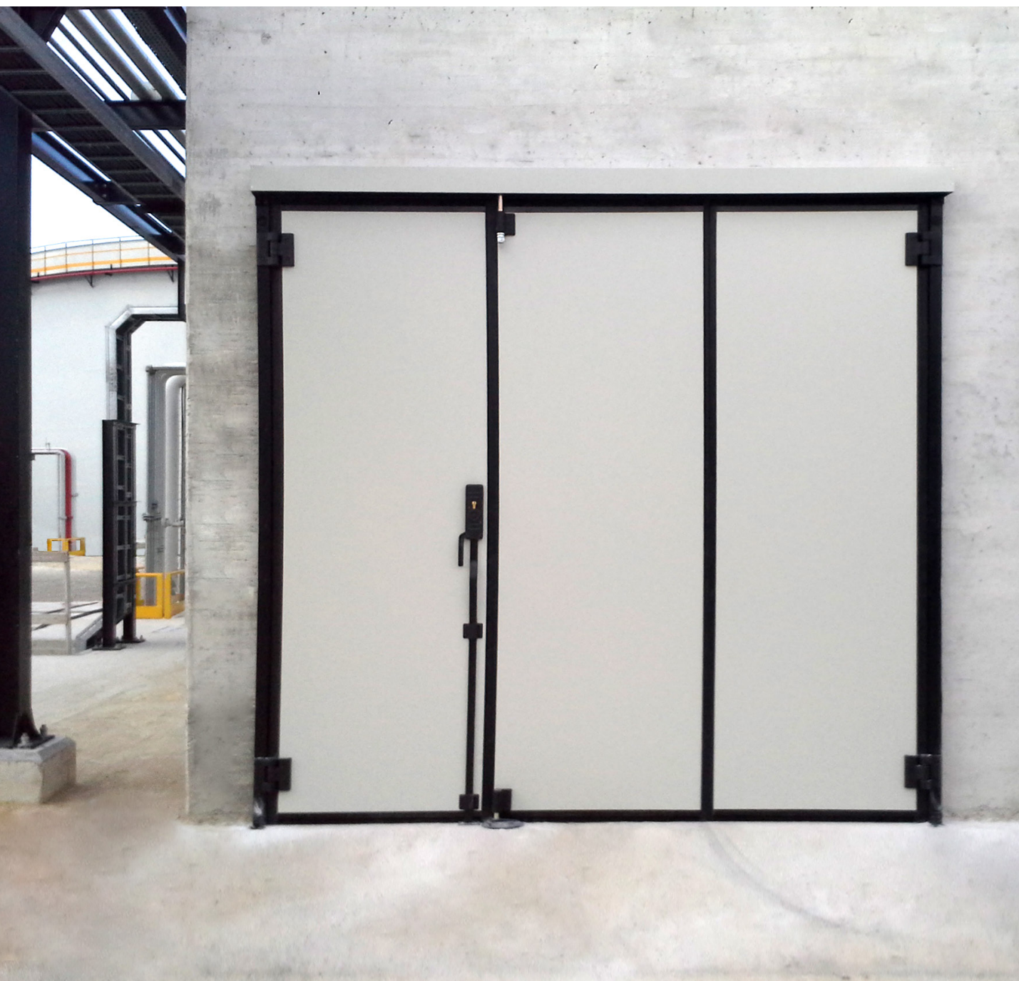
Portoni ad ante 1+2 con cariglione con chiave per apertura dall'esterno in un distributore di carburante.
